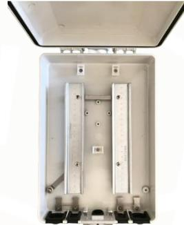
La caja terminal para módulos MX SERIE 20 TLX-20.29 ofrece una solución de alta protección contra el medio ambiente para conexiones de multipares y acometida telefónica.
